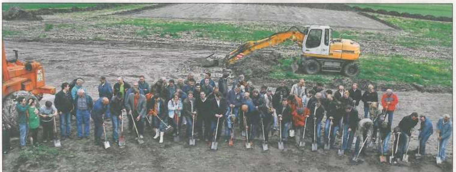
Der gemeinsame erste Spatenstich machte es deutlich: Hier entsteht ein Gemeinschaftsprojekt mit der Beteiligung von möglichst vielen Bürgern, die sich auf den Weg gemacht haben in ein neues Energiezeitalter. Im Hintergrund entsteht ein großes Silo mit drei Kammern.
